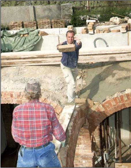
es abgebrochen. Dabei werden unglaubliche 50.000 alte Ziegel händisch aus dem „großen Schutthaufen“ herausgeklaut. Diese Steine wurden später zum Beispiel beim Bau des neuen Kellergewölbes wiederverwendet. Auch die alten Holztram werden mühsam ausgebaut und zur Einrichtung verarbeitet (z.B. zur Holzdecke im Keller).
